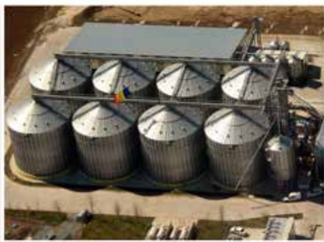
Diamètre: 16,81 m - Capacité: 3.395 T - Capacité totale: 21.000 T
