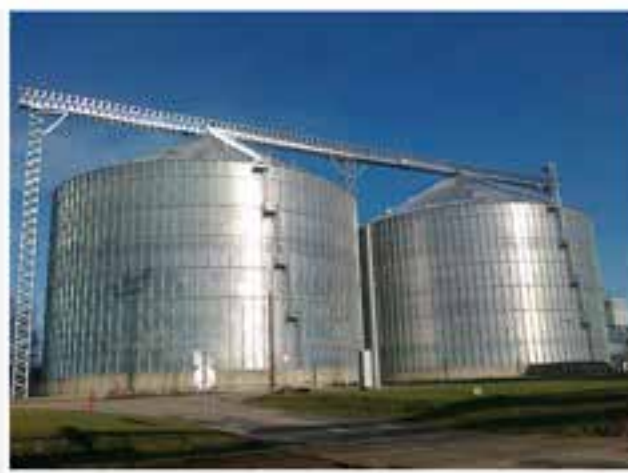
Diamètre: 41,5 m - Capacité: 26.830 T - Capacité totale: 54.000 T
