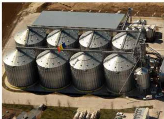
Diamètre: 16,81 m - Capacité: 3.395 T - Capacité totale: 21.000 T
