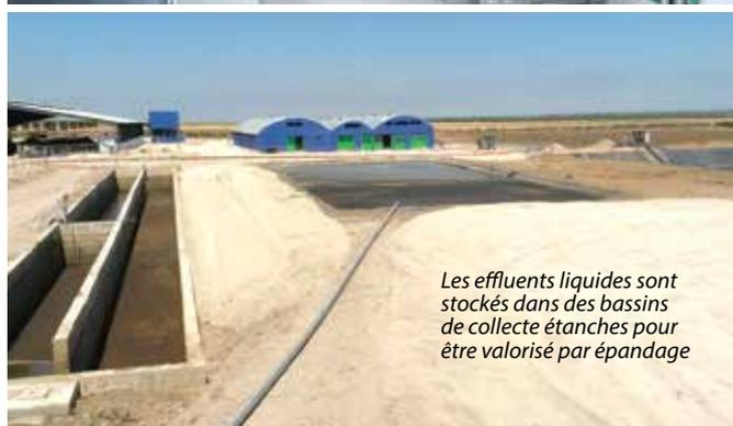
Les effluents liquides sont stockés dans des bassins de collecte étanches pour être valorisé par épandage
