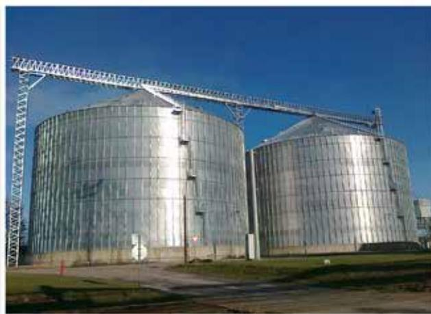
Diamètre: 41,5 m - Capacité: 26.830 T - Capacité totale: 54.000 T
