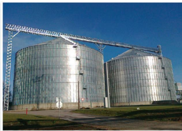
Diamètre: 41,5 m - Capacité: 26.830 T - Capacité totale: 54.000 T
