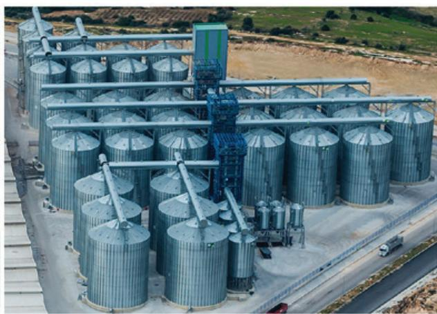
Diamètre: 18,33 m - Cap.: 5.333 T - Diamètre: 14,51 m - Cap.: 3.300 T - Cap. totale: 200.000 T
