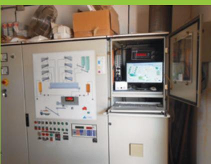
sur l'automatisation de rations programmées dans le contrôleur de l'usine, l'intervention de seulement 2 personnes. Elles sont chargées de remplir les convoyeurs et de sélectionner les rations avec un certain nombre d'ingrédients dans des proportions déterminées en fonction du type d'animal (production laitière, viande...)
