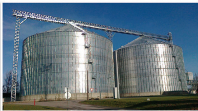
Diamètre: 41,5 m - Capacité: 26.830 T - Capacité totale: 54.000 T
