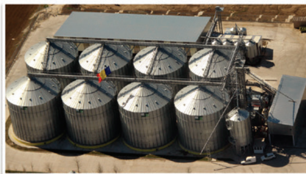
Diamètre: 16,81 m - Capacité: 3.395 T - Capacité totale: 21.000 T
