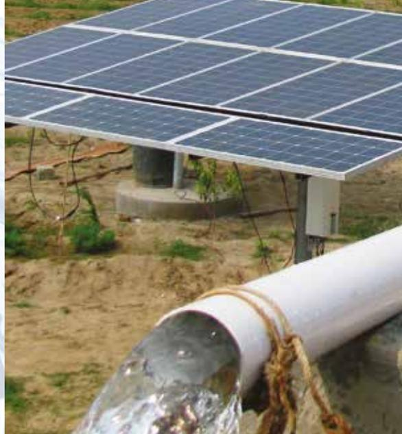
solaire à courant continu performante de 150 watts qui, à son tour, pourrait pomper plus de 1300 litres d'eau en 4 heures d'ensoleillement direct.
