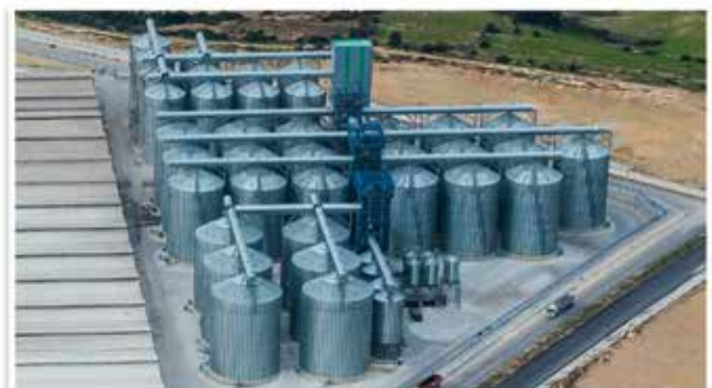
Diamètre: 18,33 m - Cap.: 5.333 T - Diamètre: 14,51 m - Cap.: 3.300 T - Cap. totale: 200.000 T
