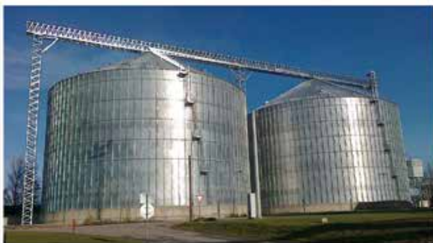
Diamètre: 41,5 m - Capacité: 26.830 T - Capacité totale: 54.000 T
