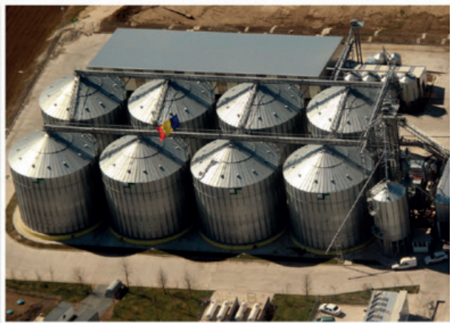
Diamètre: 16,81 m - Capacité: 3.395 T - Capacité totale: 21.000 T
