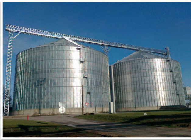
Diamètre: 41,5 m - Capacité: 26.830 T - Capacité totale: 54.000 T
